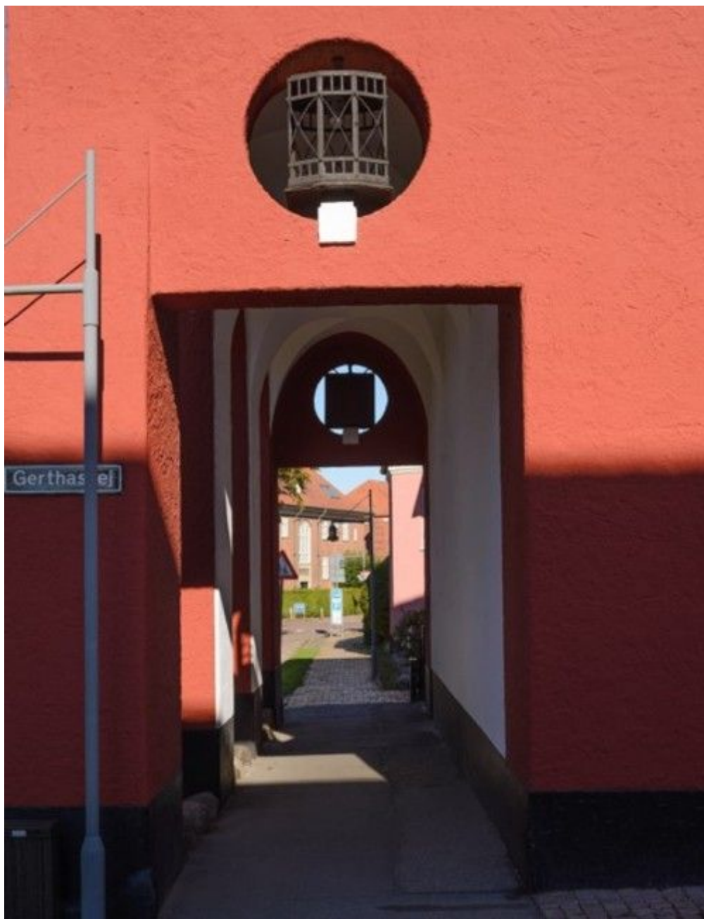
Udsnit af port mod Vandværksvej.
